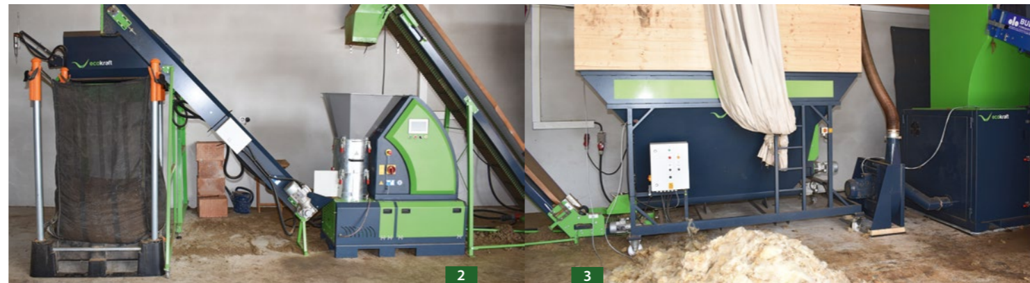
4 Die Rohwolle von anderen Schafhaltern wird in Big Bags bei Markus Hofmann angeliefert. 1 Beide Produkte verkauft Markus Hofmann über verschiedene Vermarktungswege. 2 und 3 Von der Schneidmühle (rechts) über den Vorratsbehälter gelangen die Woll-Flusen über ein Förderband in die Pelletpresse und weiter in den Abkühlsack.
